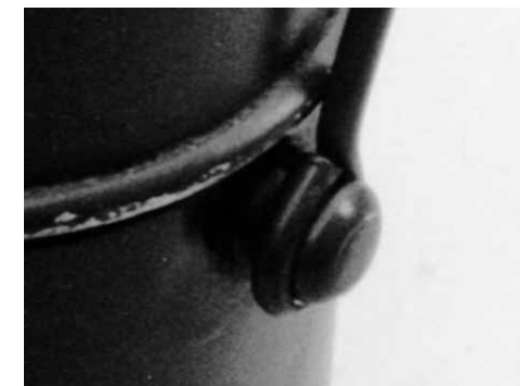
Fig. 12: Protubérance rivée (angle de rotation de la poignée de transport donc 360°)
