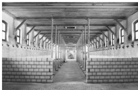
Mise en place d'une paroi de protection incendie.
