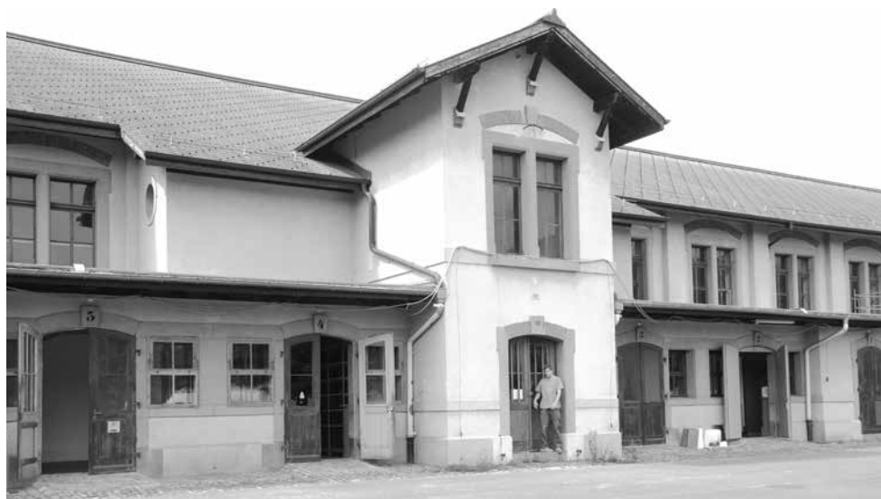
C'est ici que le Shop de la VSAM a établi ses nouveaux quartiers (portes 1 à 5).
