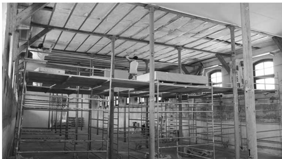
Pose de l'isolation et du plafond.
