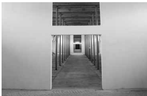
Paroi de protection incendie achevée.
