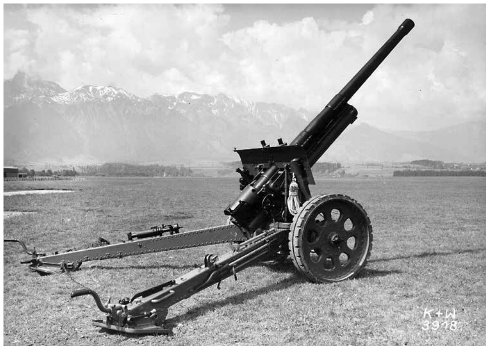
Canon 10,5 cm ord. 1935 L 42, dans sa version originale Bofors, au cours des essais à Thoune, avec frein de bouche à trous et pneus pleins.
