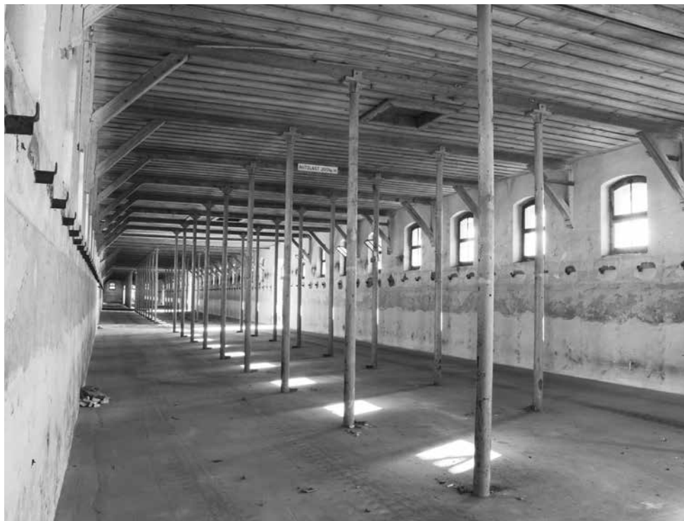
Retour à l'état d'origine pour les ailes latérales.
