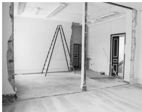
Démolition des parois intermédiaires dans le bâtiment en saillie.
