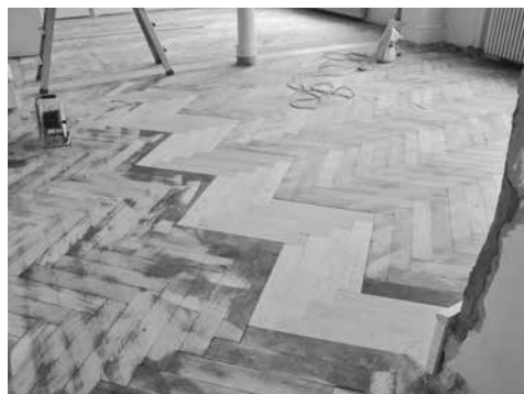
Réparation de l'ancien parquet
