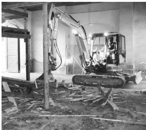
Travaux de démolition.
